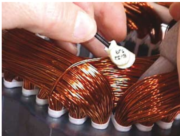
Figura 5.5 - Instalação do termostato na cabeça da bobina
